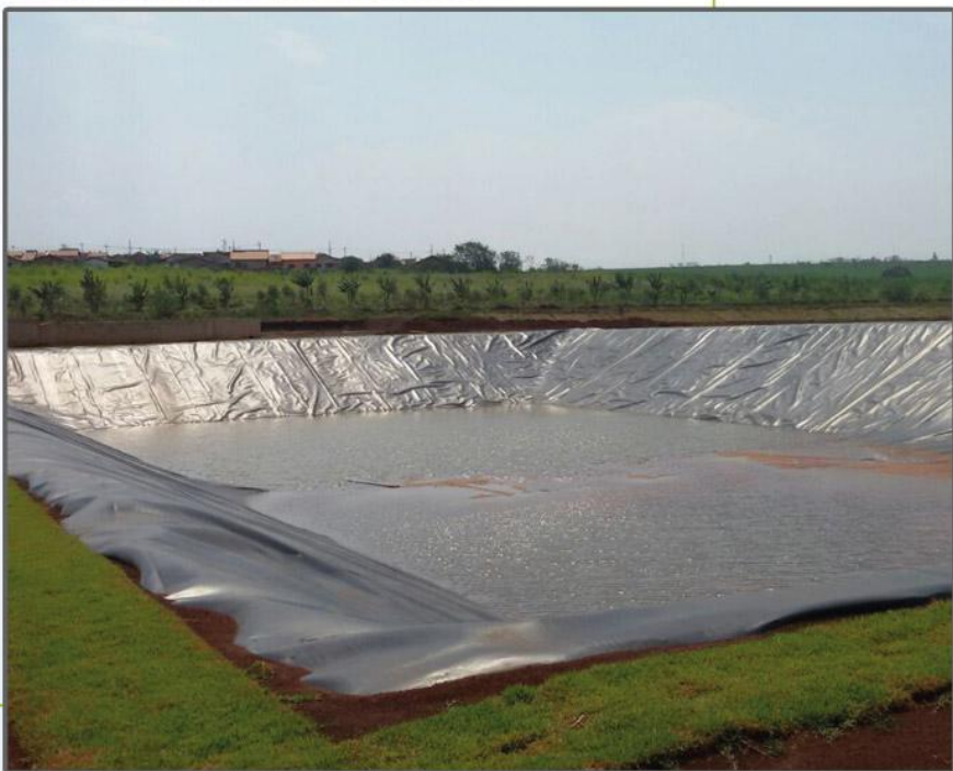
Reservatório de Efluentes
