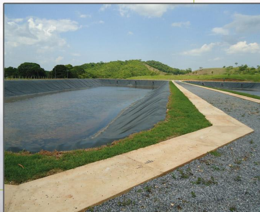
Reservatório de Água
